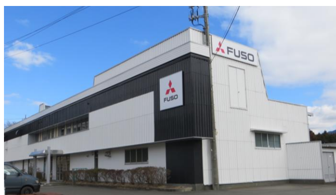
御殿場支店の外観
