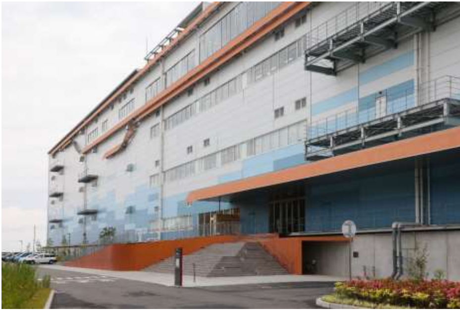
「ESR 幸浦ディストリビューションセンター1」内に位置する「幸浦部品センター」
